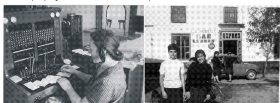
Central de teléfonos La Bodega-Bar Llamas
