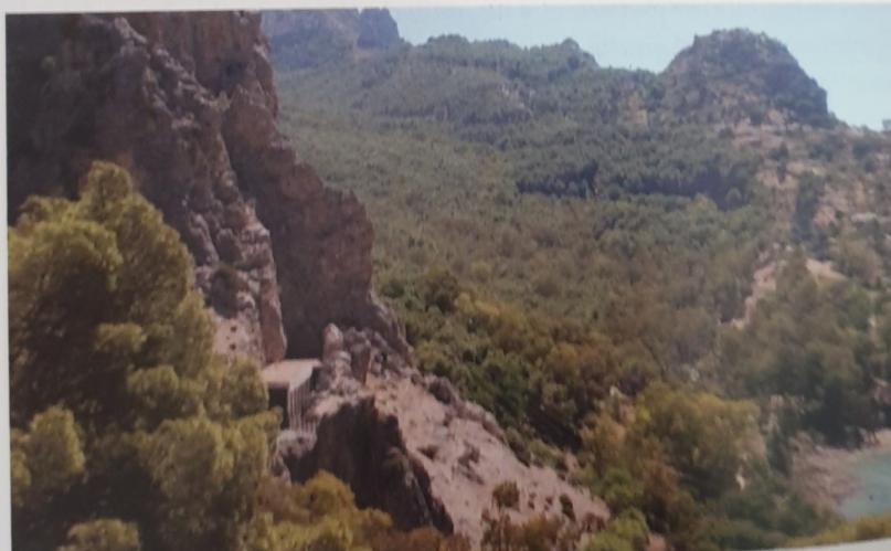
El mismo lugar, en 2014. En 1894 desapareció el viaducto curvo del Chorro. A la izquierda se ve un trozo de la prolongación del túnel de la Fuente que lo preserva de la caída de piedras.
