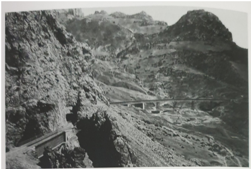
Viaducto curvo del ferrocarril Córdoba-Málaga cruzando el valle Haza del Río. A la izquierda se ve el puente de La Fuente o Josefona, de fabricación metálica. Fotografía: J. Spreáfico, 1867.
