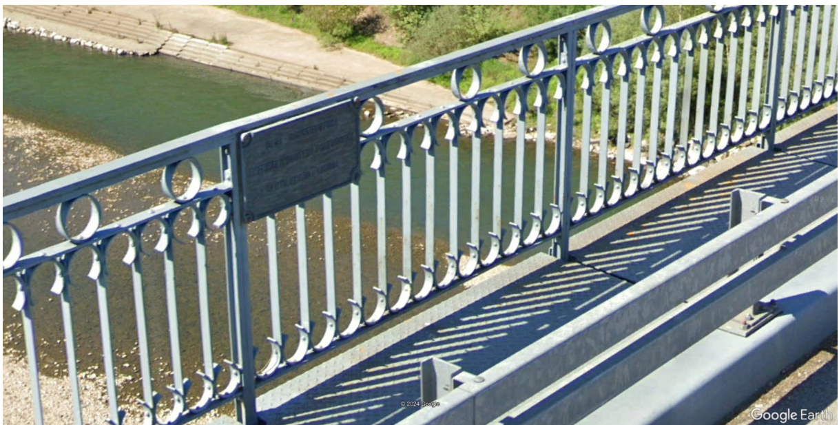
Barandilla del puente sobre el río Zézere
